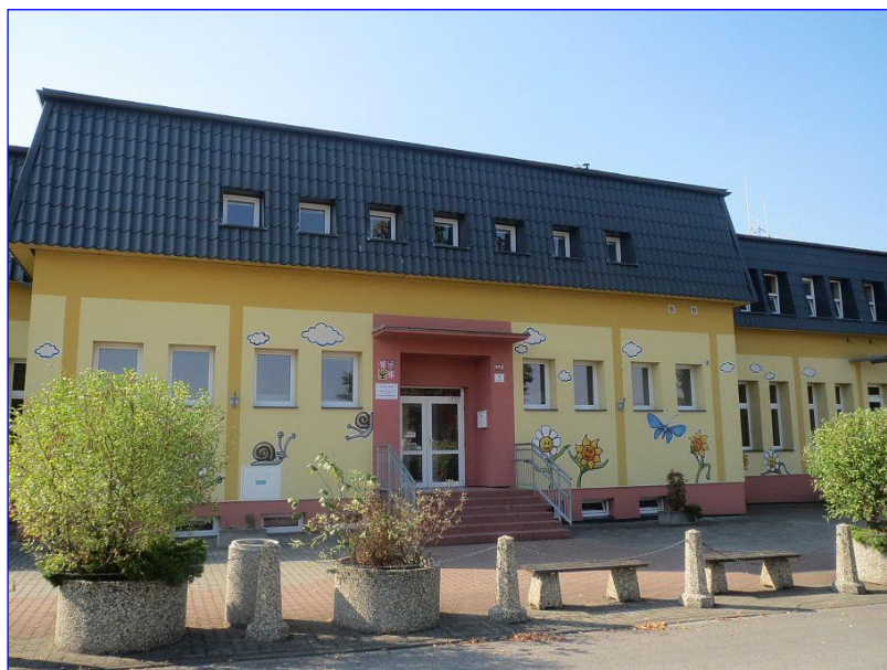
Obrázek 2 - Budova ZŠ v srpnu 2015
